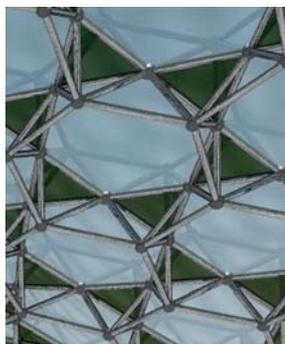
Abbildung 9. Von einem CP-Dreiecksnetz abgeleitete Strukturen. Oben: Packung mit Kugeln, welche die Inkreise der Facetten orthogonal schneiden. Unten links: Approximative Kreispackung (blau). Unten rechts: Hybrides Dreiecks- und Sechsecksnetz mit ebenen Facetten und Tragstruktur.
